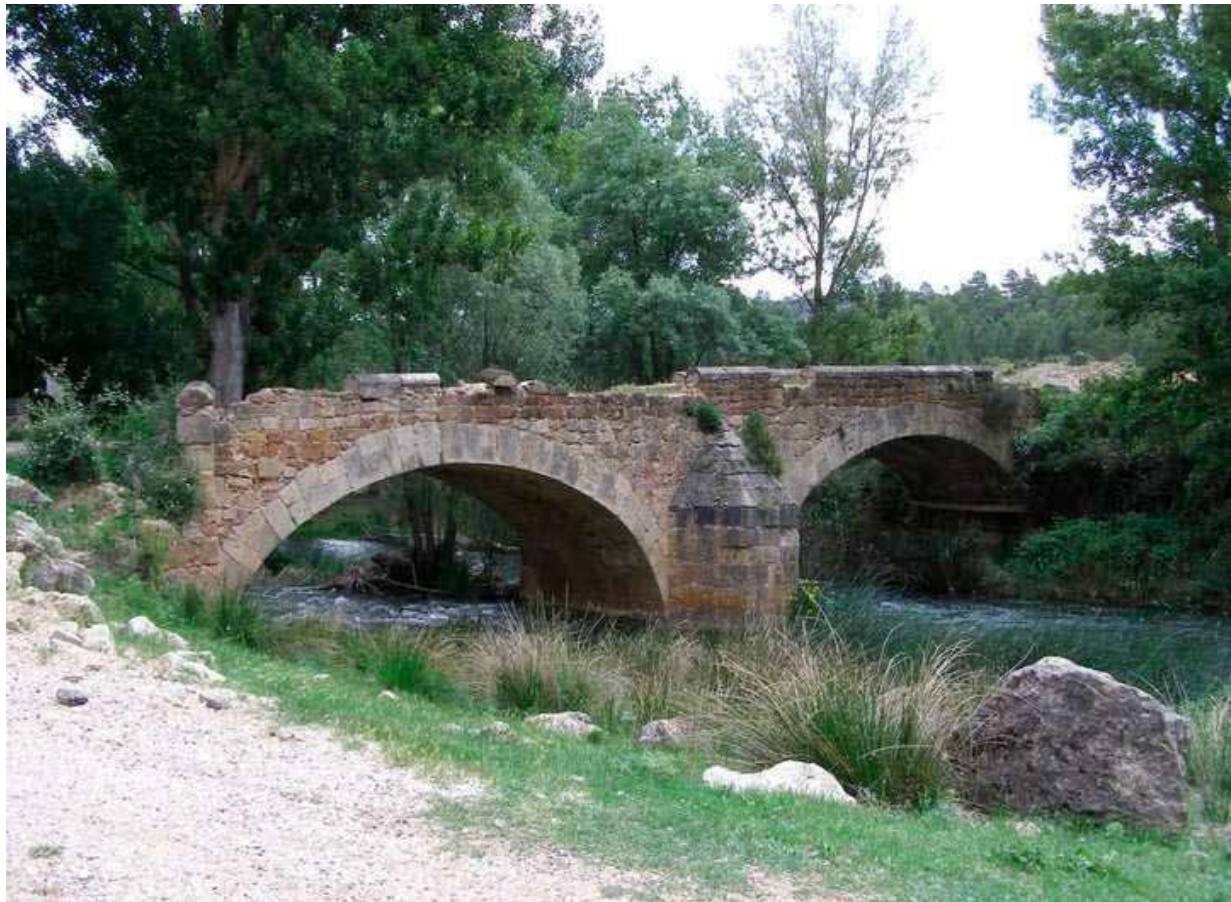
Puente Cristinas (Pajaroncillo). La memoria describe en la zona de Cristinas una presa que movía un molino de dos piedras y una antigua herrería reconvertida en batán.
