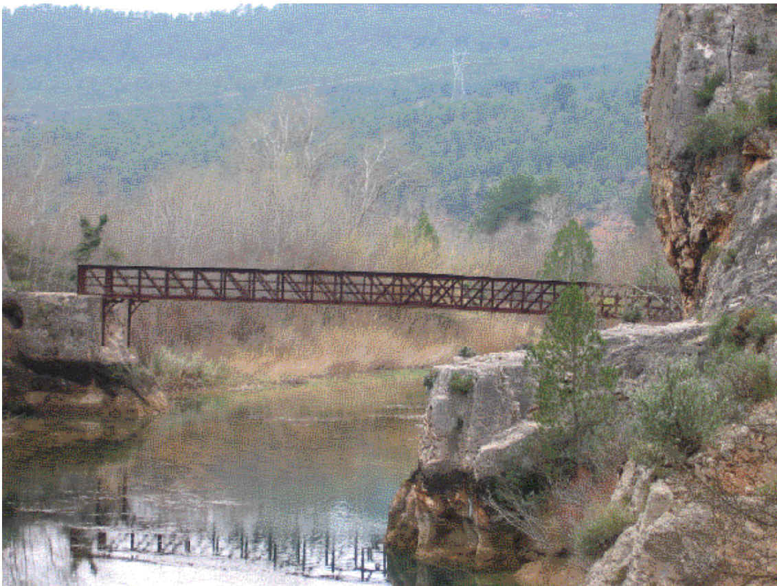
Puente de Hierro en Los Cuchillos de la Fonseca (Minglanilla, Venta del Moro, Villargordo) donde según la memoria se ubicaba una antigua presa que movía dos ruedas verticales de cajones y un molino harinero de dos muelas en la margen izquierda. Se regaban 150 hanegadas en la orilla manchega y 100 en la valenciana.
