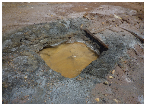
Pozo de extracción de agua salada en Jaraguas. Julio de 2011
