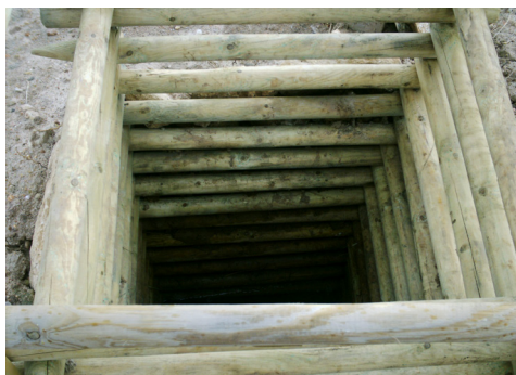
Restauración pozo central de las salinas. Jaraguas noviembre de 2006
