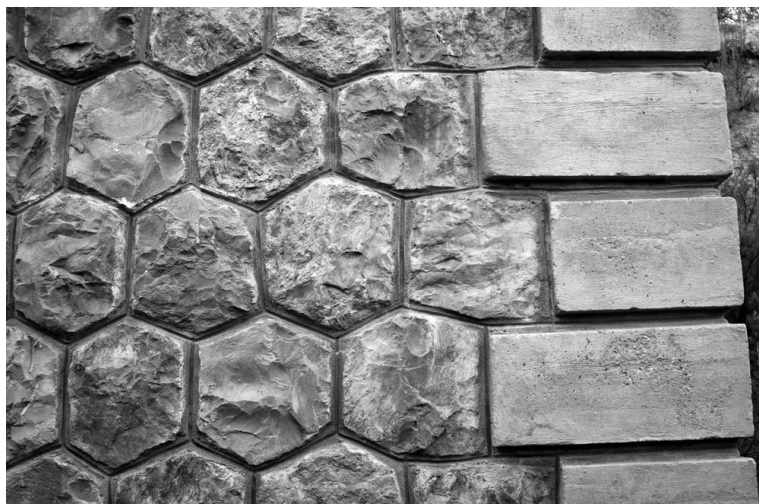
Imagen 7. La marca de calidad de la obra del Baeza-Utiel está presente hasta en la infraestructura más modesta.
