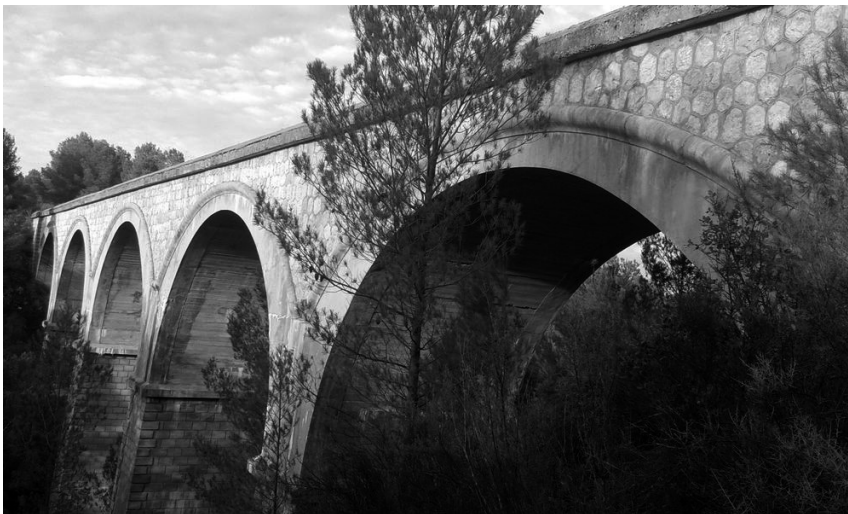
Imagen 14. Viaducto del barranco Varejo
