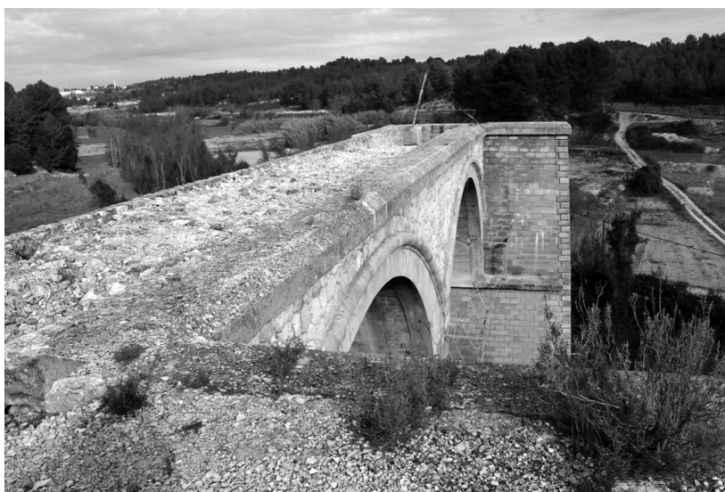
Imagen 1. Puente del Rebollo sobre la rambla Albosa
