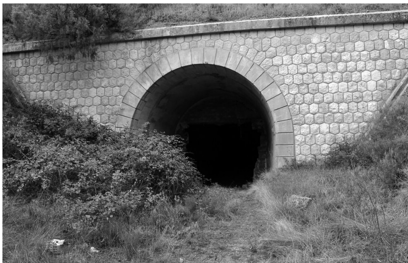
Imagen 9. Túnel 25. Las Covatillas
