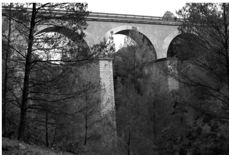
Imagen 8. Viaducto barranco del Moro
