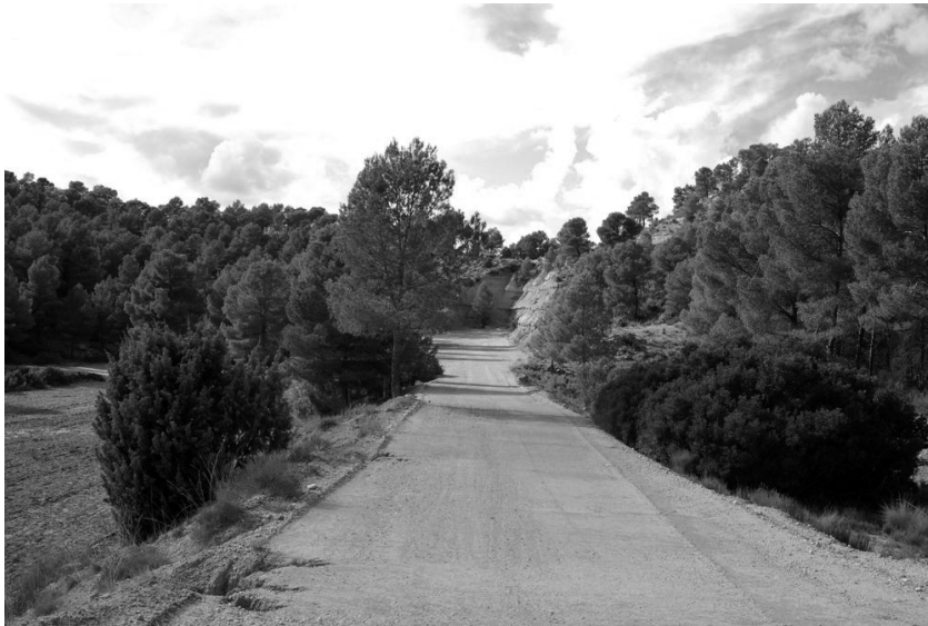
Imagen 13. Vía explanada en Peñón Hundido
