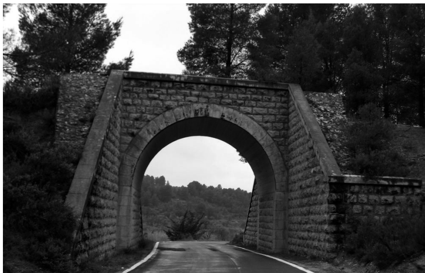
Imagen 10. Puente la Vía en carretera de Venta del Moro – Los Isidros
