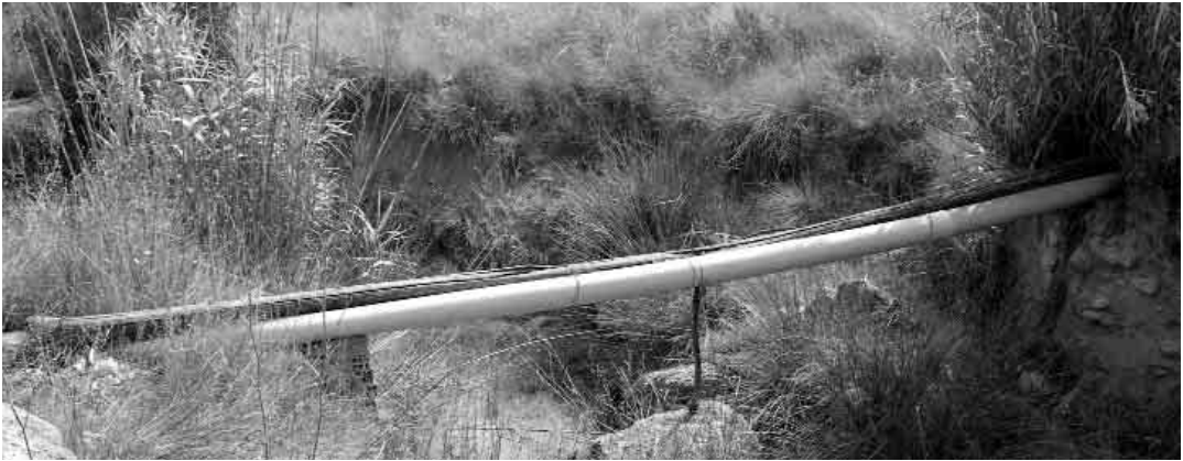
ACEQUIA DE LA CANAL (Rambla Albosa en proximidades a Venta del Moro)
