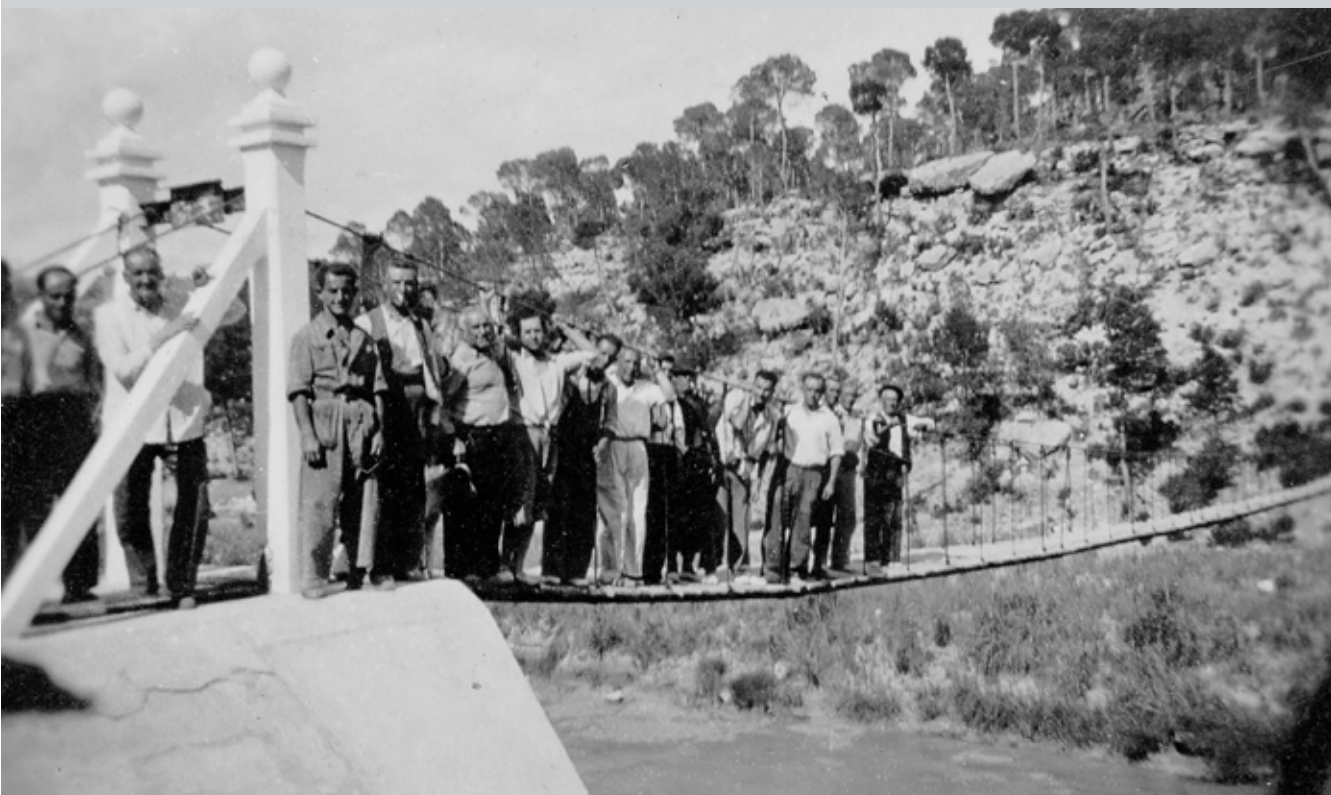
Puente colgante de El Tete
