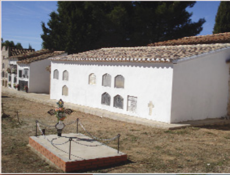
Rehabilitación del Cementerio Viejo
