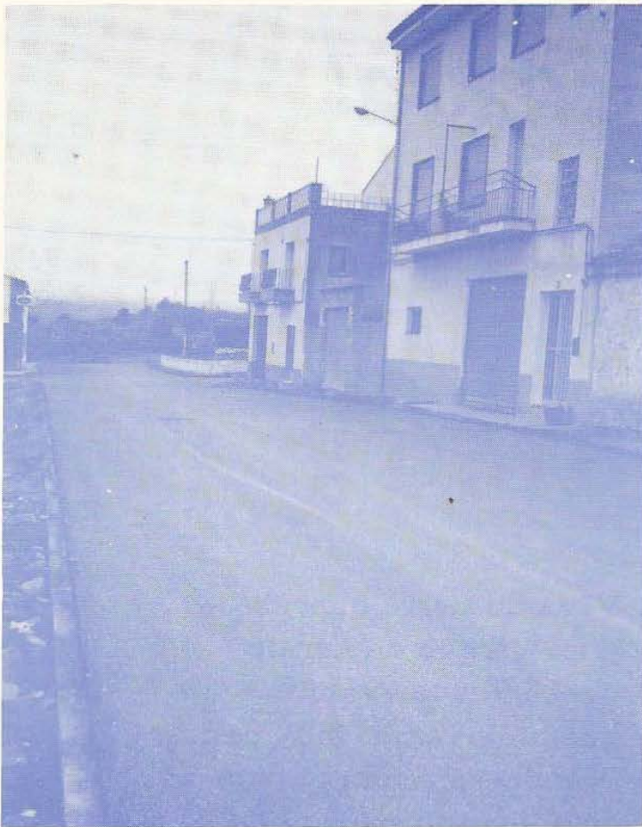
Acceso zona oeste
