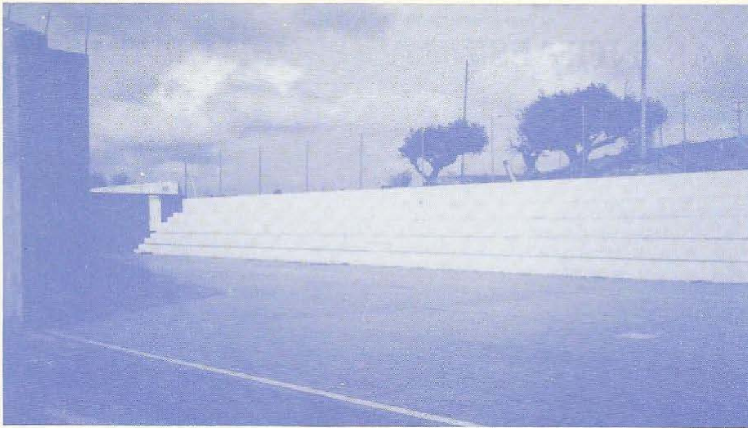
Gradas frontón y vallado del mismo
