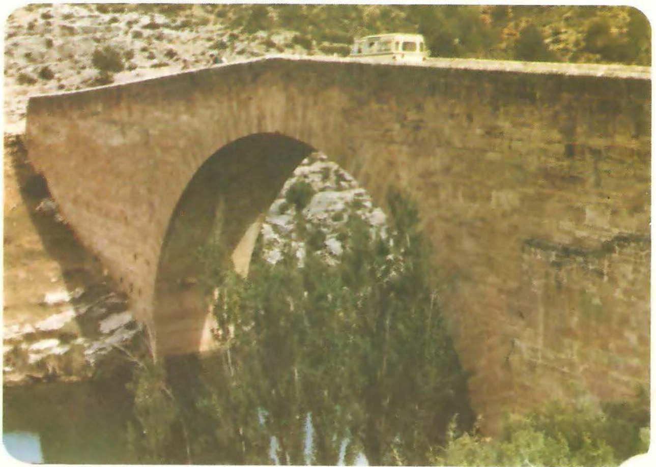
Puente de Vadocañas, base y fundamento de la historia venturreña. Sólida obra de origen romano.
