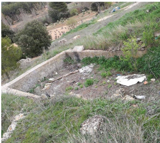
Balsas de destilación de espliego en Casas del Rey. Foto Nacho Latorre.
