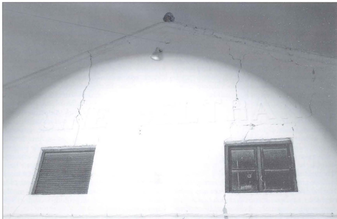
Fachada del Cine Beltrán construido en 1.952
