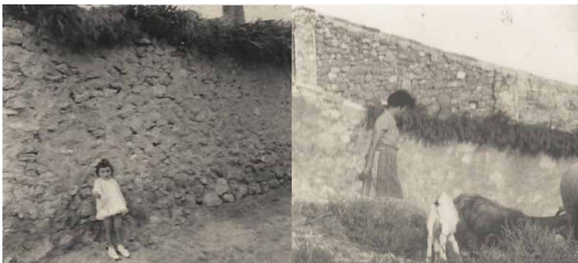
Muros de tapia irregular con sus garbas de pino sobre el muro
