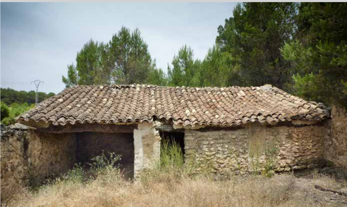
Cubierto de un corral de ganado cerca de la Casilla del Cura (Venta del Moro). Sección de la construcción protegida de las inclemencias climáticas con una entrada amplia.
