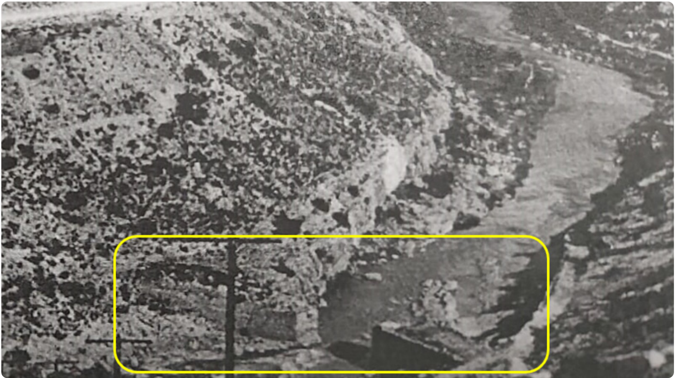
Figura 2 Estribos de sillería del puente de piedra descrito por Pedro Cortijo. Fotografía tomada a mediados del s. XX desde el lado Cuenca, mirando hacia aguas abajo.
