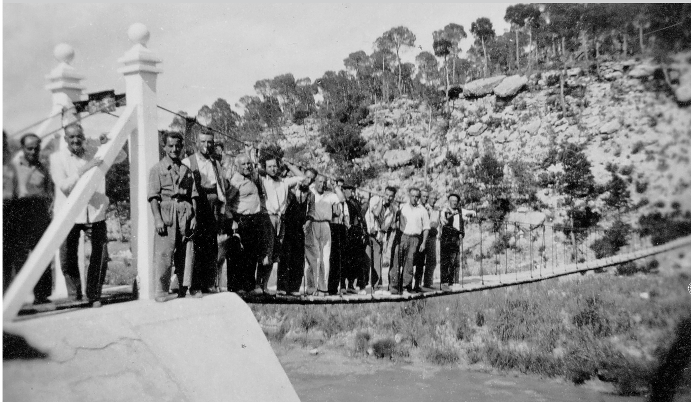
Puente colgante de El Tete
