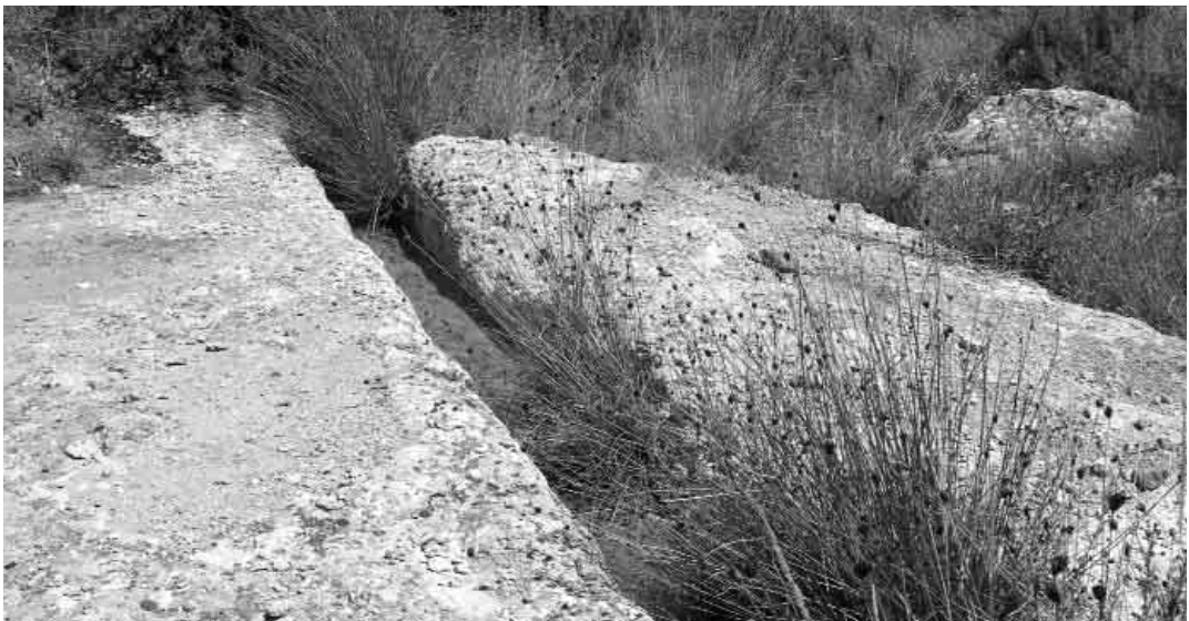
Toma de agua de la ACEQUIA DE VAREJO
