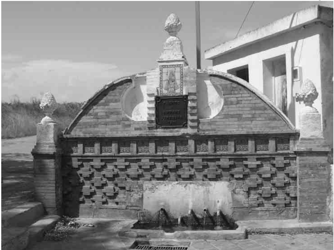
FUENTE AMPARO en la entrada de Jaraguas
