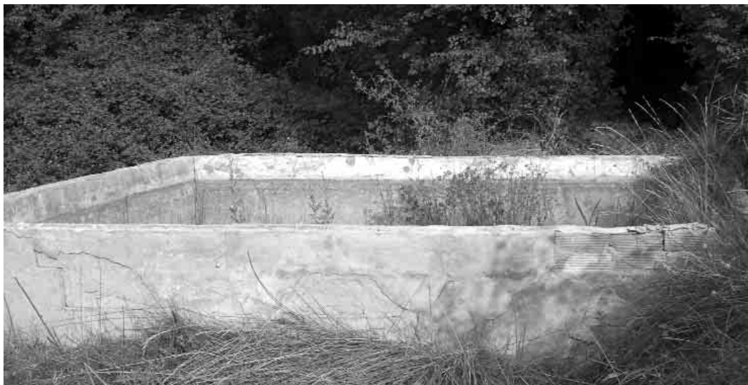
Elemento de acumulación: Balsa de la Acequia de los Olmos (Casas del Rey)
